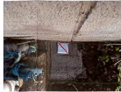
P1境界標(新設金属標)
