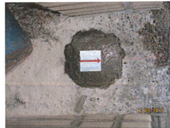
測点Q4新設金属標
