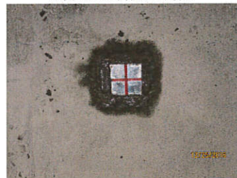
測点Q3新設金属標
