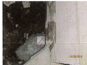
測点Q6新設金属標
