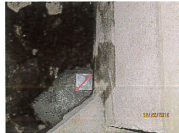
測点Q6新設金属標
