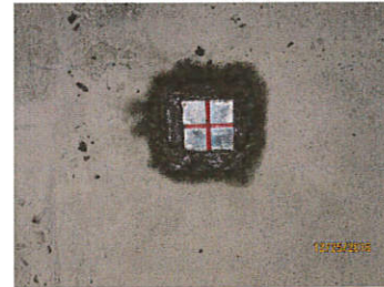
測点Q3新設金属標
