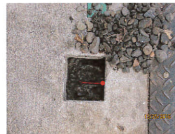
測点Q2既設コンクリート杭
