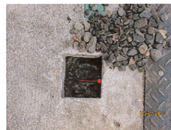
測点Q2既設コンクリート杭
