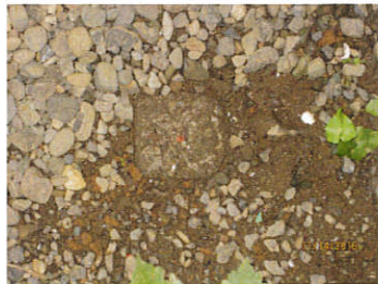
測点N31既設コンクリート杭
