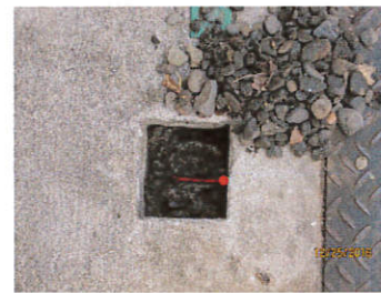
測点Q2既設コンクリート杭
