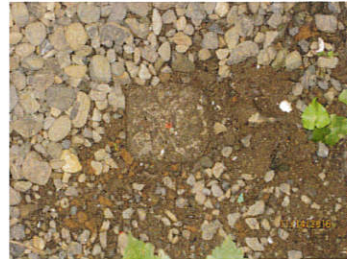
測点N31既設コンクリート杭
